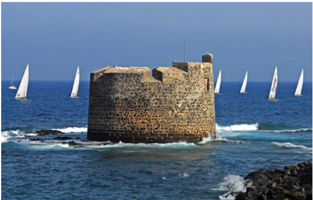
Fortaleza de San Pedro, en la orilla del mar, sobre una formación rocosa que hace de base natural. (Barrio de San Cristóbal, Cono Sur). Fuente: www.grancanaria.com
