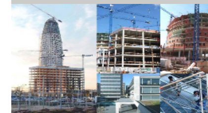
Fig. 3. Estado de ejecución Torre Agbar: septiembre 2005.
