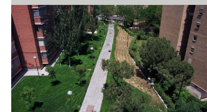
Fig. 5. Pavimento permeable y conducción subterránea en el Parque de Gomeznarro.
