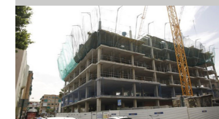
Fig. 5. Obras en el barrio de Santa Adela.
