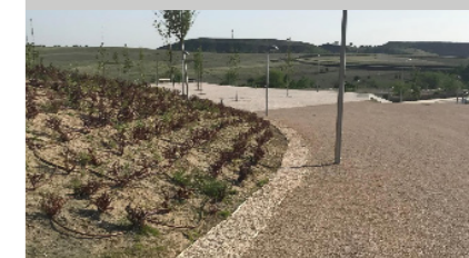
Fig. 6. Zanjas de infiltración en La Atayuela, Madrid.
