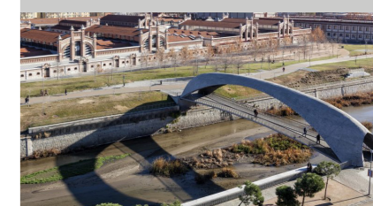
Fig. 11. Imagen de pasarela sur Puente de Praga.
