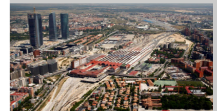
Fig. 4. Fotografía del estado en el que se encuentra actualmente parte del área de actuación.
