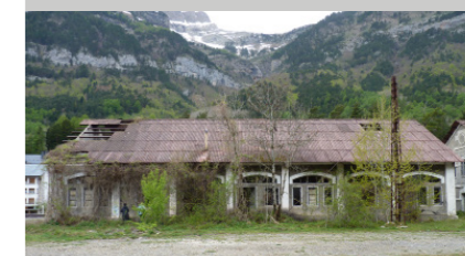
Fig. 3. Edificio sanitario. Estado anterior.
