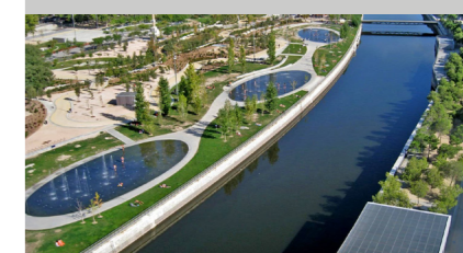
Fig. 4. Imagen de Parque Madrid Río finalizado.
