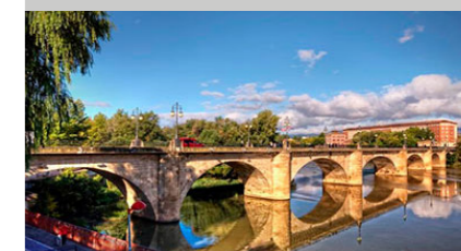
Fig. 3. Fotografía del puente de piedra de Logroño, tramo del Camino de Santiago restaurado.
