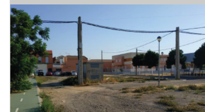
Fig. 9. Centro de transformación existente (Estudio de Detalle).
