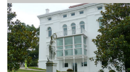
Fig. 10. Fotografía de una fachada de la Casa Blanca en la finca del Marqués de Valdecilla, Santander.
