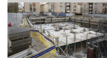
Fig. 4. Obras en el barrio de Santa Adela.
