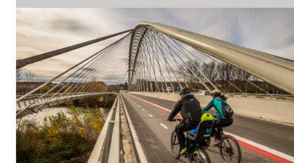
Fig. 6. Carril bici en el puente de Sagasta.
