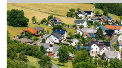
Fig. 11. Placas fotovoltaicas en el medio rural.
