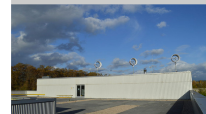
Fig. 6. Vista de la azotea del Aquavox.
