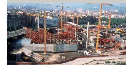
Fig. 5. Fotografía del museo Guggenheim durante la fase de construcción.
