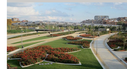
Fig. 3. Imagen de Parque Madrid Río finalizado.
