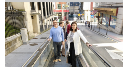
Fig. 3. Propuesta de rampa portante para facilitar el acceso a las instalaciones hospitalarias, itinerario 3.
