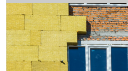
Fig. 10. Rehabilitación energética de edificios.
