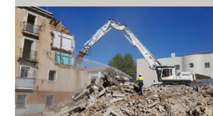
Fig. 3. Derribos de inmuebles en la actuación.
