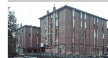
Fig. 3. Estado preoperacional del barrio.
