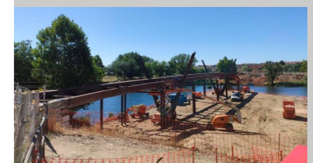
Fig. 5. Imagen de la pasarela en construcción.
