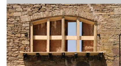
Fig. 4. Refuerzo de huecos en fachada.
