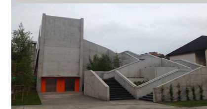
Fig. 10. Ascensor y escaleras que une las calles Alta y Castilla.
