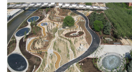
Fig. 5. Imagen de Parque Madrid Río finalizado.
