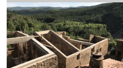
Fig. 5. Refuerzo estructural con vigas de hormigón.
