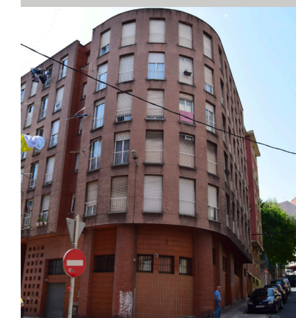
Fig. 2. Renovación de las fachadas y cubiertas de 14 portales del Patronato.
