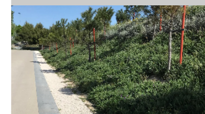
Fig. 11. Dren filtrante en Madrid Río.
