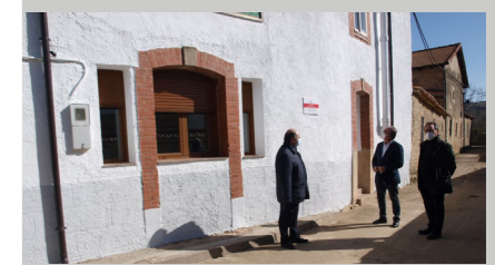
Fig. 11. Rehabilitación del Programa Rehabitare de una vivienda en Pomar de Valdivia.
