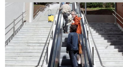
Fig. 5. Escaleras mecánicas frente al comienzo de la calle Cuesta del Hospital, itinerario 5.
