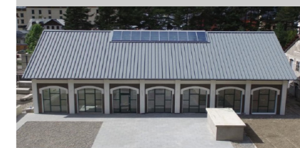
Fig. 4. Edificación sanitario rehabilitado, Centro de Acogida a Peregrinos.
