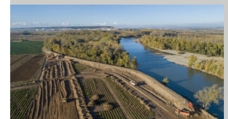
Fig. 10. Obras de construcción de nueva mota.
