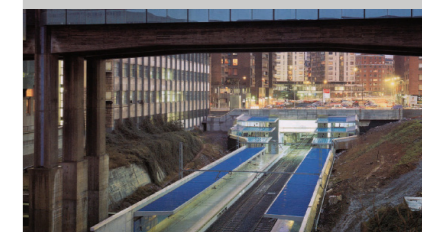
Fig. 6. Fotografía de la estación de metro de San Mamés.
