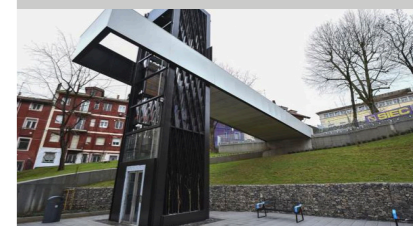
Fig. 6. Ascensor entre el pasaje de Peña y el Cabildo, itinerario 5.
