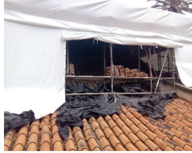
Lona que cubre la nave central y norte
