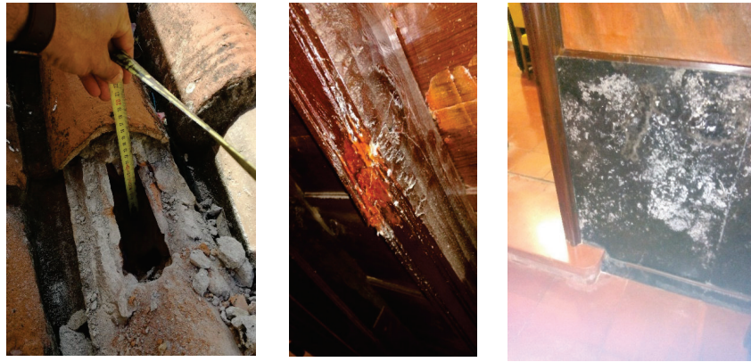
Cata de la losa de hormigón.
