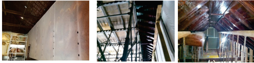
Imágenes del proceso de protección de las pinturas murales de la nave central.
