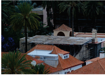
Cimbra de protección de la nave central y norte
