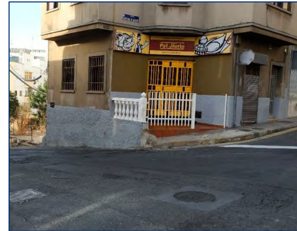
Pérdida de continuidad en la senda peatonal (la acera acaba y el peatón se ve obligado a circular por la calzada) en la calle Agustina de Aragón, esquina con calle Tormento.
