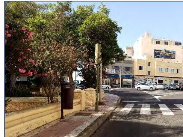
Interrupción del normal tránsito de peatones por la acera junto a la plaza Ramoncito El Fontanero producida por el báculo del semáforo.
