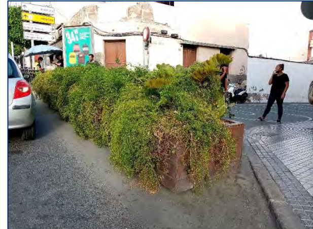
Macetones de delimitación de acceso vehicular en el tramo de peatonal de la calle Jacinta con evidente falta de mantenimiento.
