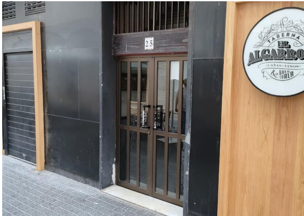
Ilustración 14: Imagen de la fachada del local EL AGARROBO.
