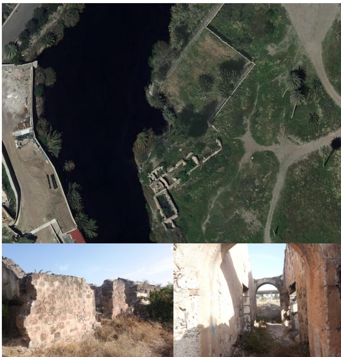
Estructuras ruinosas externas al Bien de Interés Cultural y junto a la Presa de Tamaraceite
