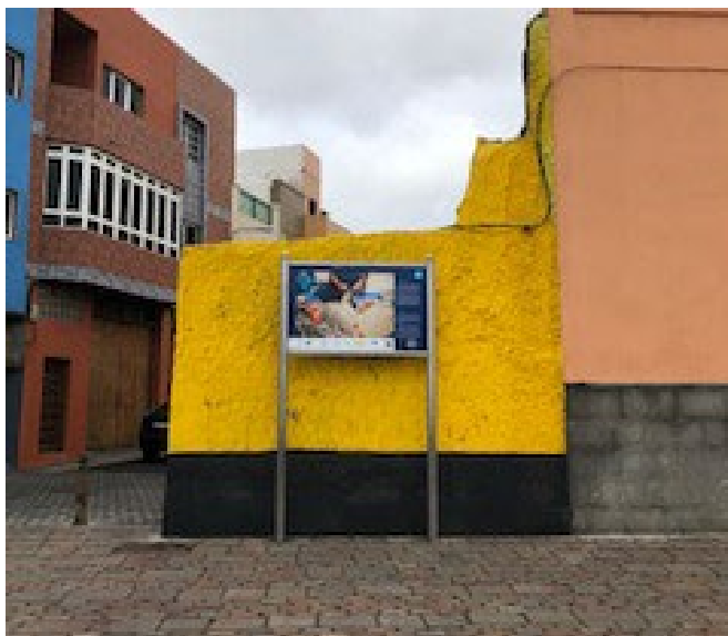
Fachada calle Marina
