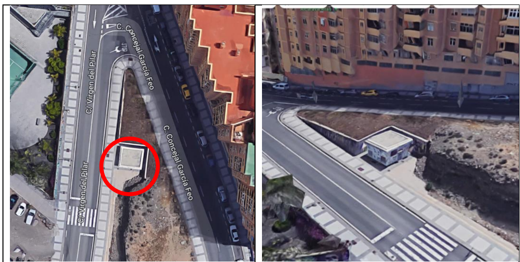
Situación de la Estación Transformadora. Fuente: Google Maps
