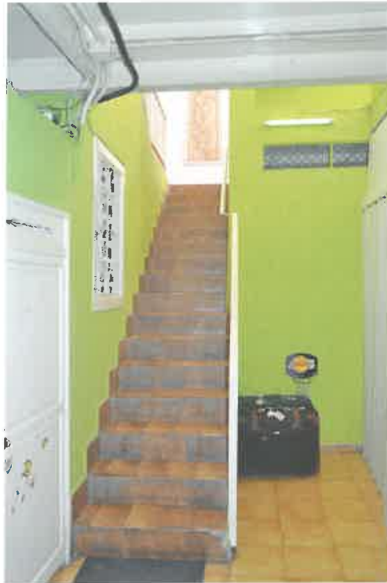
Portal y escalera a vivienda en planta baja
