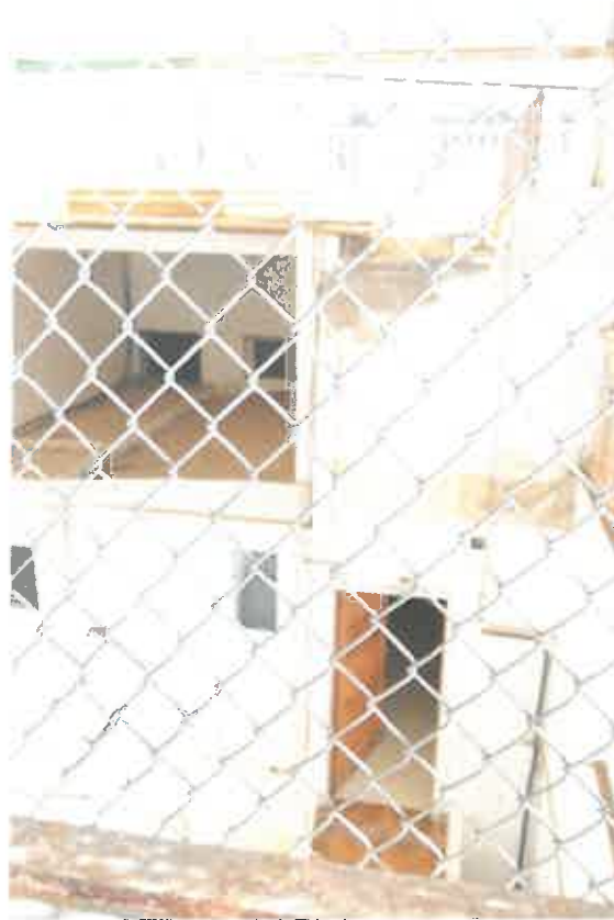
Fachada Oeste al patio de escaleras
