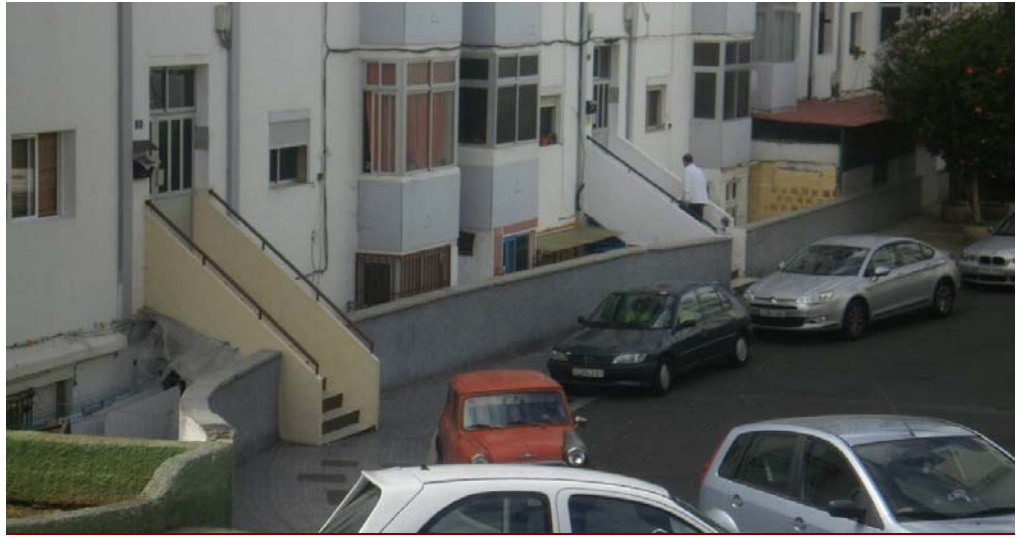
Acceso por debajo de la rasante (foto superior) y por encima (foto inferior) de la rasante.
