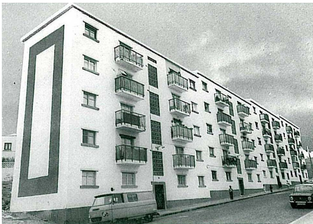
Imagen de un bloque de viviendas en Tamaraceite.
