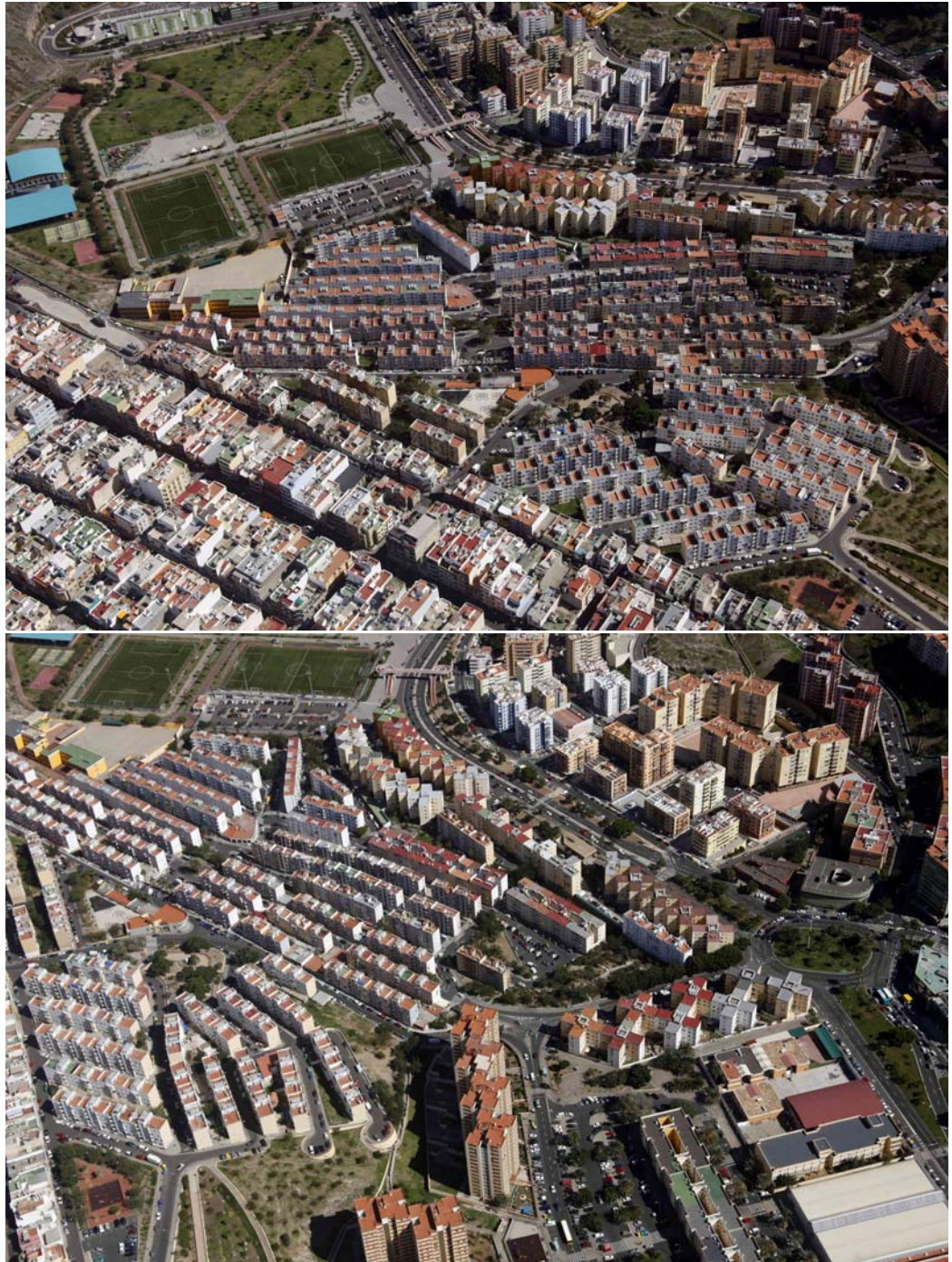
Relación formal y funcional con el Parque de Las Rehoys y Schamann (arriba) y Polígono Cruz de Piedra (abajo).
