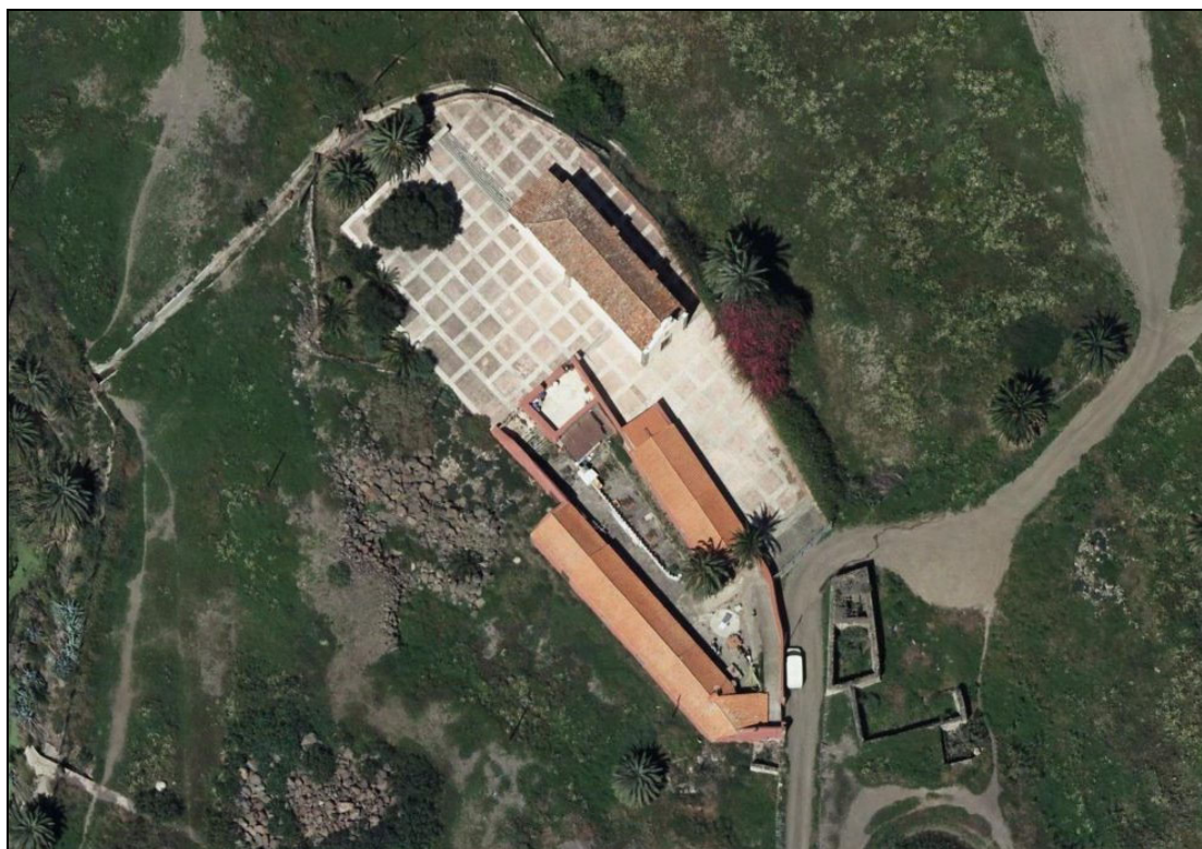
Estructuras ruinosas junto al perímetro externo al Bien de Interés Cultural
