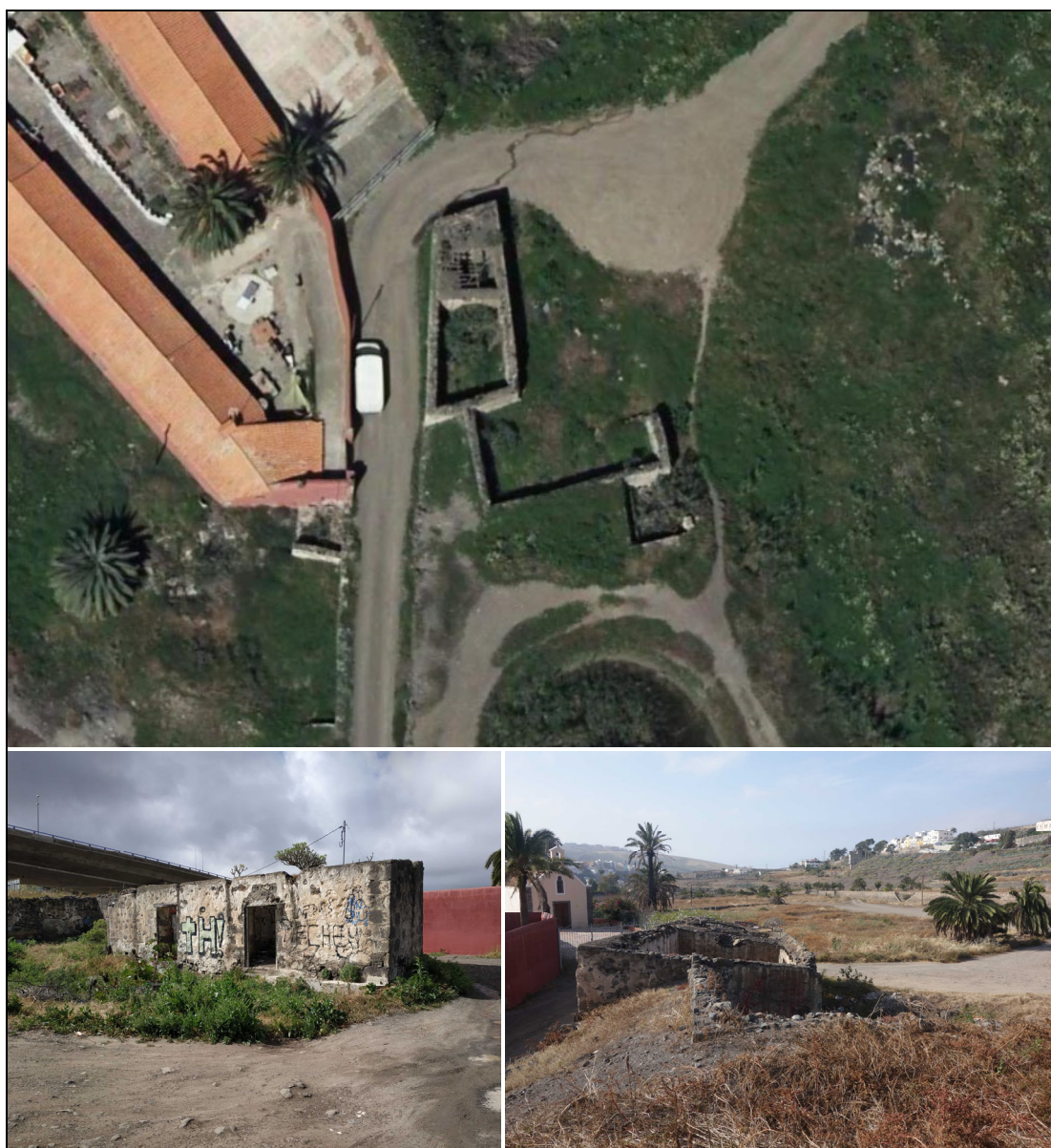
Estructuras ruinosas junto al perímetro externo al Bien de Interés Cultural
