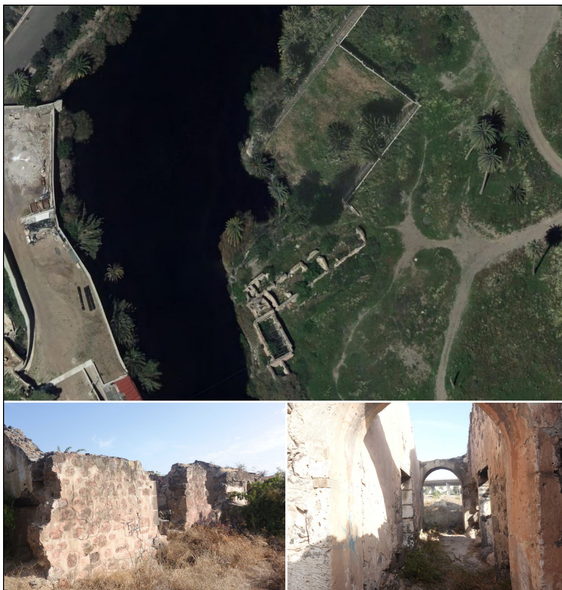
Estructuras ruinosas externas al Bien de Interés Cultural y junto a la Presa de Tamaraceite
