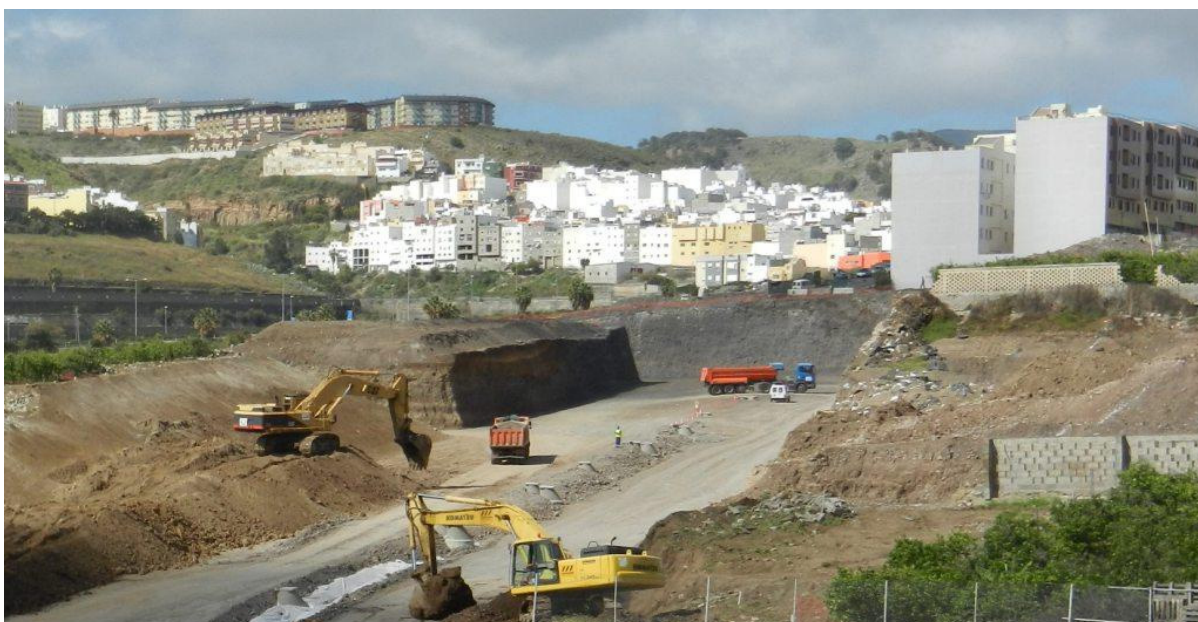
Fotografía 12. Trabajos de desmorte junto al barrio de La Suerte
