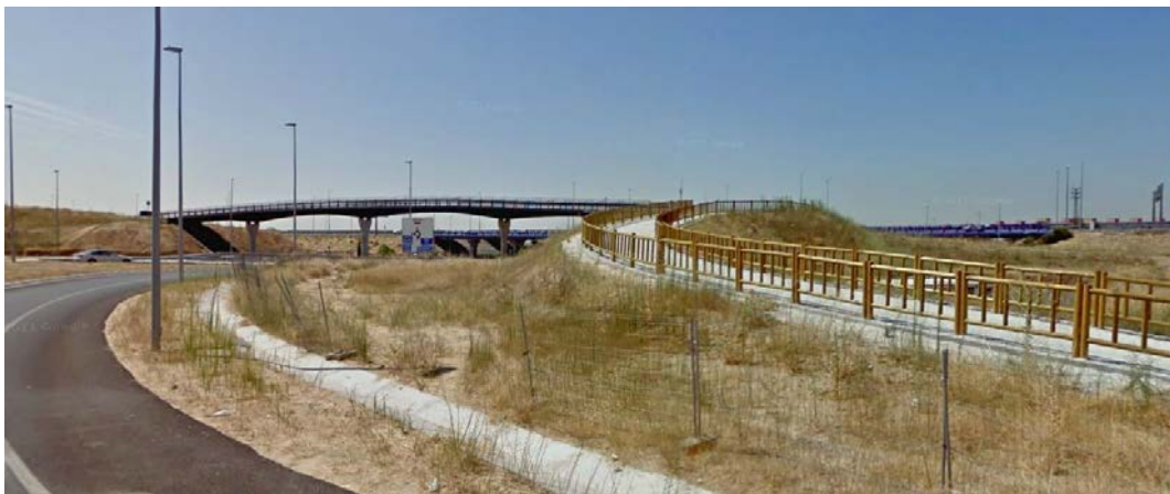
Ilustración 46. Pasarela de conexión de espacios libres en el Ensanche Sur de Alcorcón
