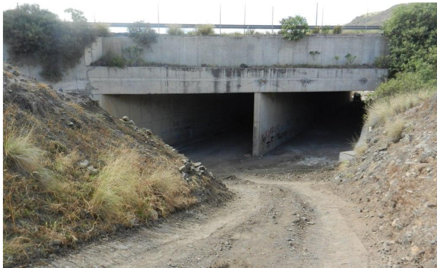
Fotografía 11. Paso bajo la autovía GC-3 del barranco de Tamaraceite y calle Viejo
