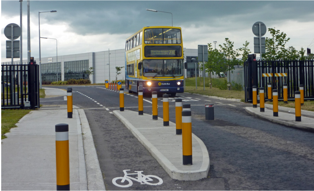
Fotografía 13. Paso solo bus y bici. Dublín 55
