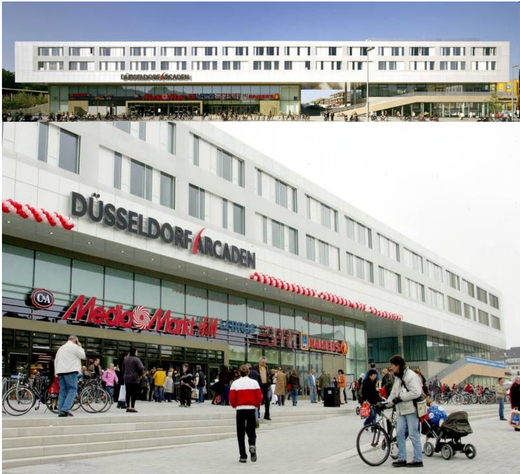
Ilustración 52. Fachada comercial en Düsseldorf
