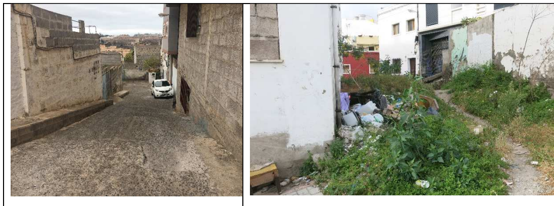
Figura 43. Estado actual de algunos viales interiores
