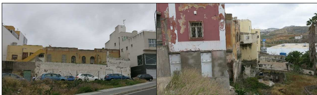
Figura 30. Medianeras vistas sin tratar. Fuerte impacto en los bordes.
