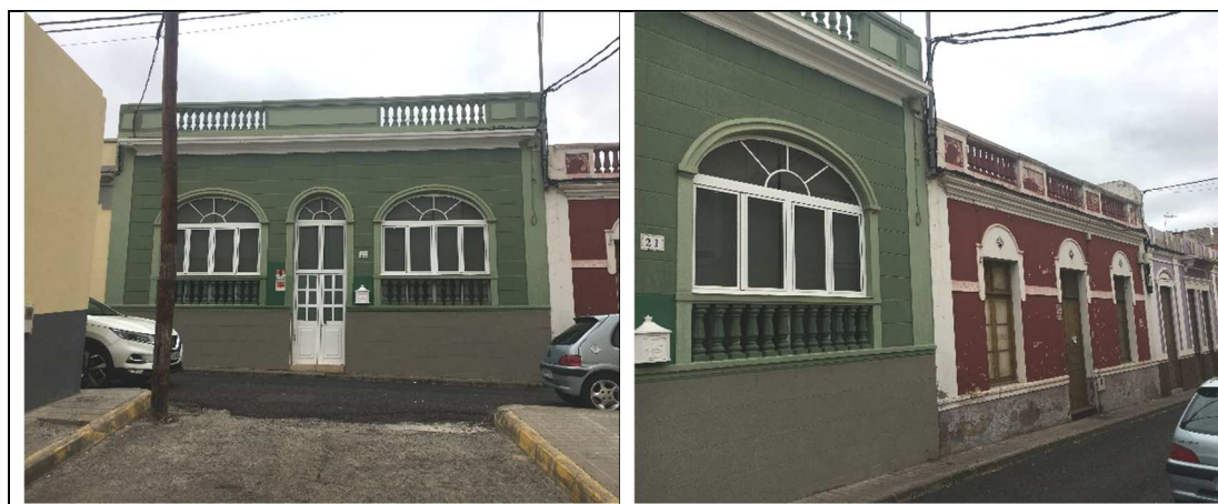
Figura 8. Grupo de viviendas de una planta del año 1.900 en Paseo de Los Mártires.
