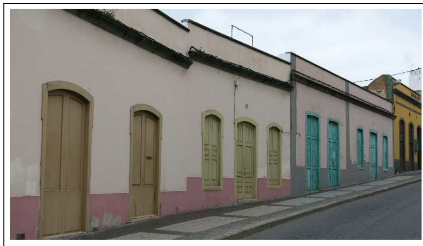
Figura 10. Casas terreras del año 1920 en Carretera General.
