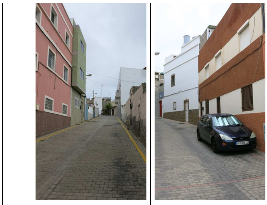
Figura 22. Aspecto general de rodonales adoquinados del interior.
