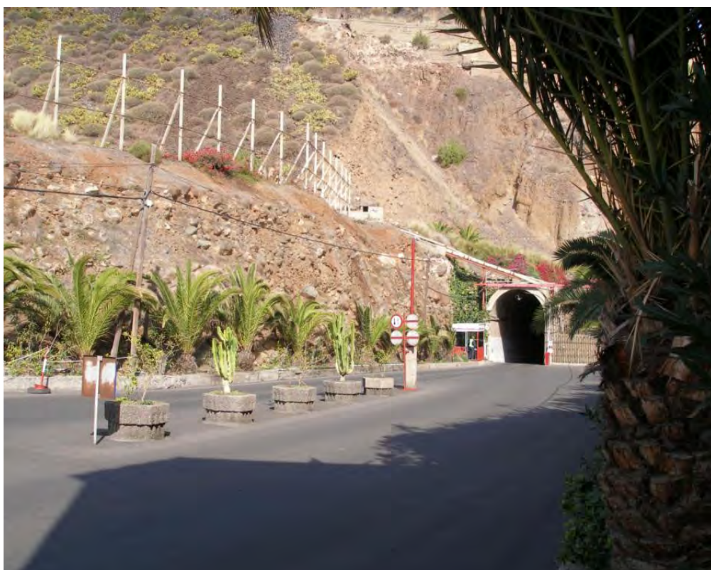
La imagen muestra la zona de confluencia entre el vial de acceso a las diferentes dependencias del Complejo Industrial de Aguas Minerales de Firgas en la zona del Rincón, y el túnel que establece su conexión con el viario general exterior.
