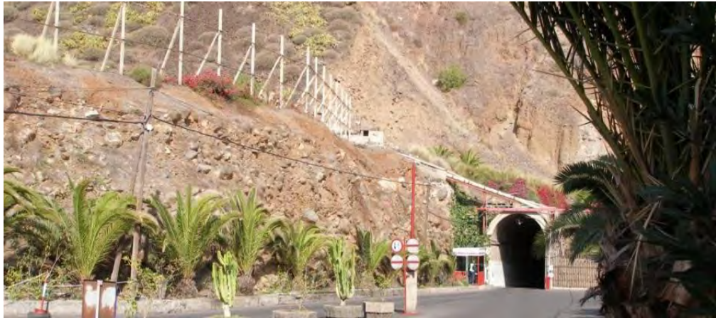
La imagen muestra la zona de confluencia entre el vial de acceso a las diferentes dependencias del Complejo Industrial de AGUAS MINERALES DE Firgas en la zona del Rincón, y el túnel que establece su conexión con el viario general exterior.
