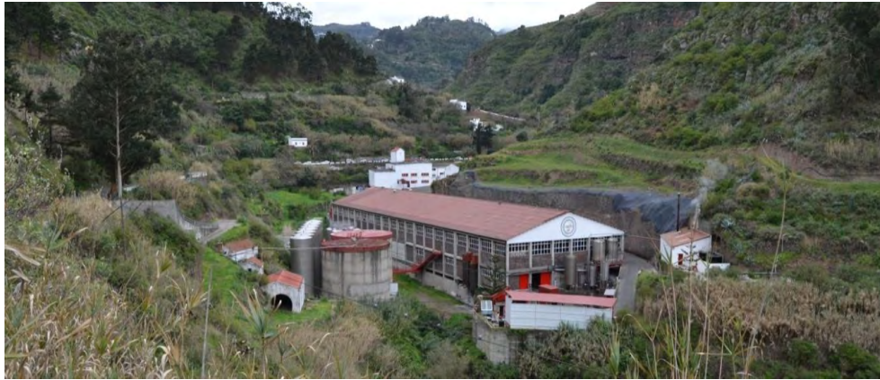
Instalaciones de AGUAS MINERALES DE Fargas, S.A. en Barranco de las Madres (T.M. Fargas)
