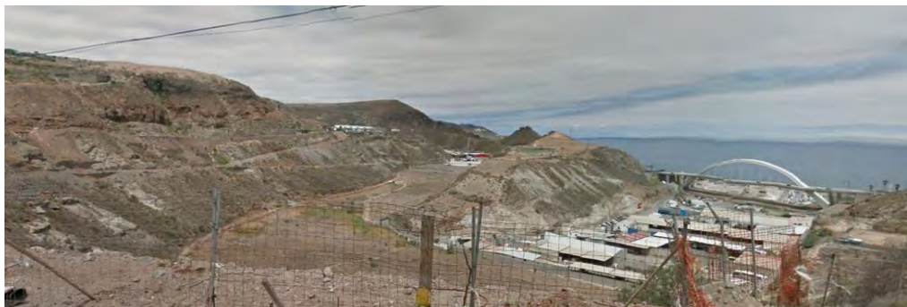
PV. 1: Visión que se tiene del ámbito del Complejo de AGUAS MINERALES DE Firgas en el Bco. de Tamaraceite desde la zona residencial del Barrio de Chile (residencias con vistas orientadas al ámbito de estudio) y desde la carretera adyacente a dichas viviendas GC-340.
