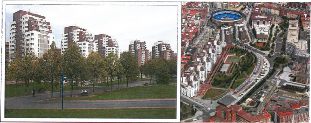
Relación del conjunto edificado de alta volumetría con zonas de espacios libres y dotaciones. Amézola, Bilbao.
