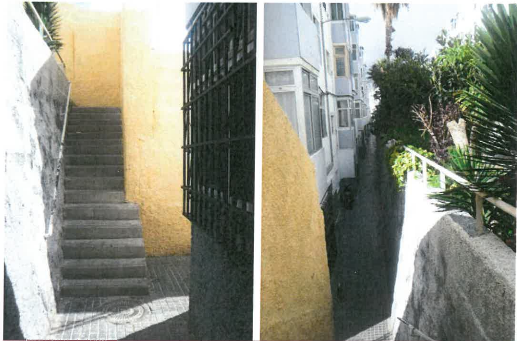
Más ejemplo de falta de coordinación entre rasantes y accesos.
