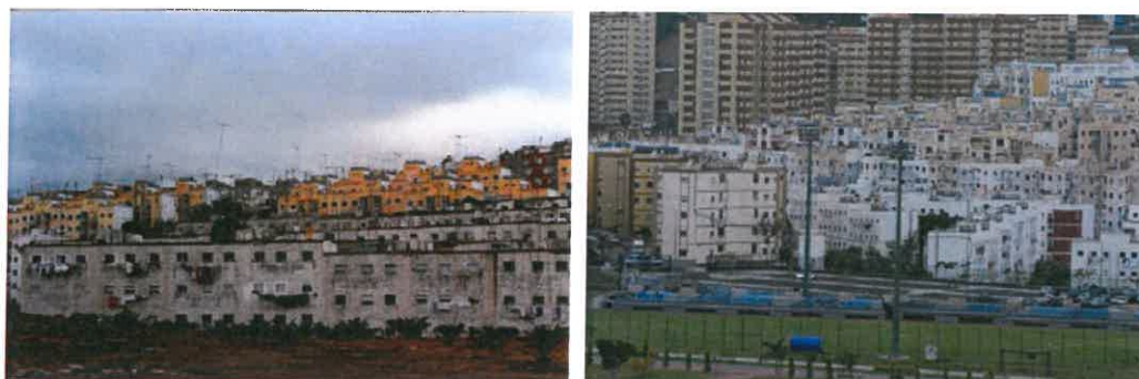
Imagen anterior (izquierda) y posterior (derecha) a la rehabilitación.
