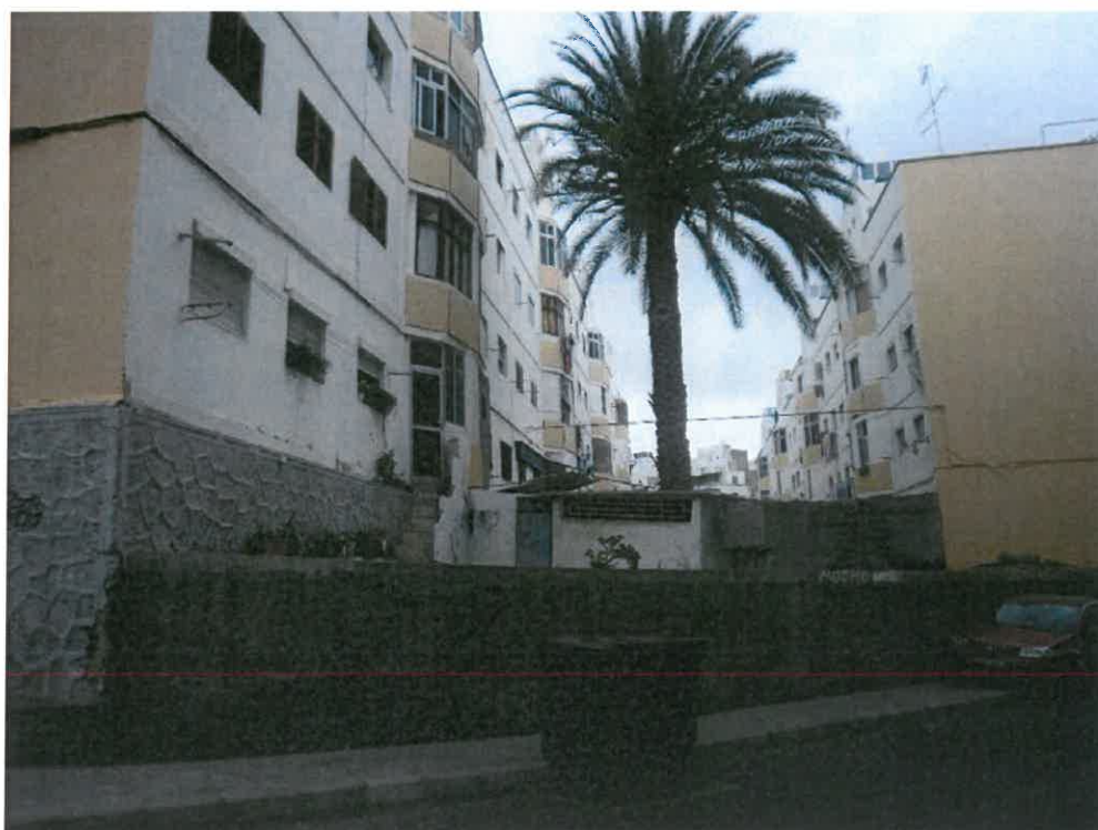
Detalle sobre la invasión de espacio libre comunitario.
