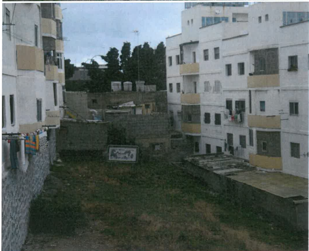
Detalles sobre la invasión de espacio libre comunitario.
