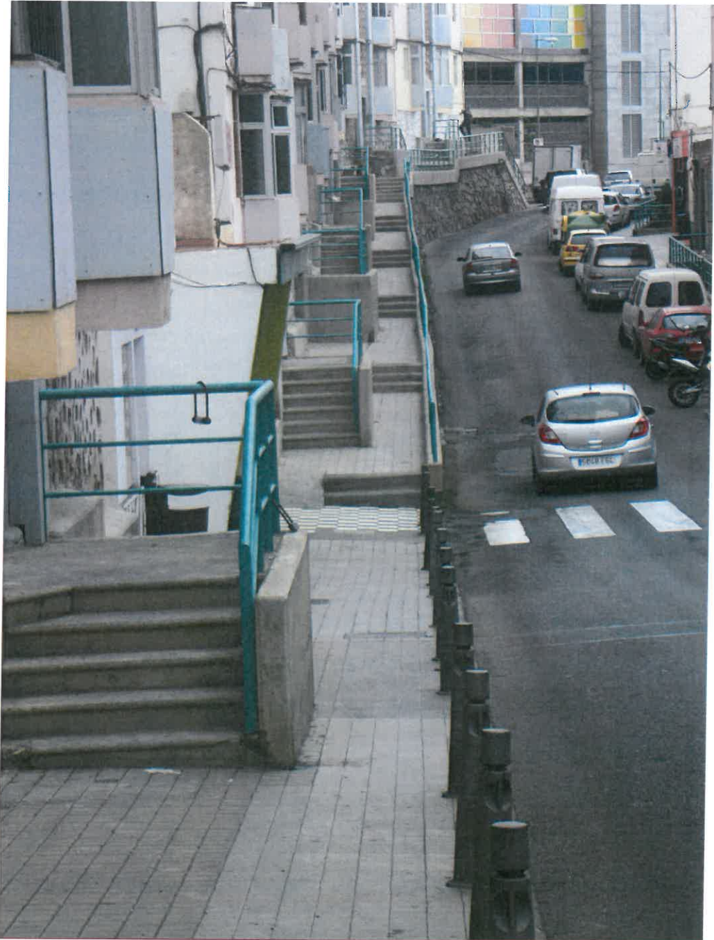
Acceso a los bloques por encima de la rasante.
