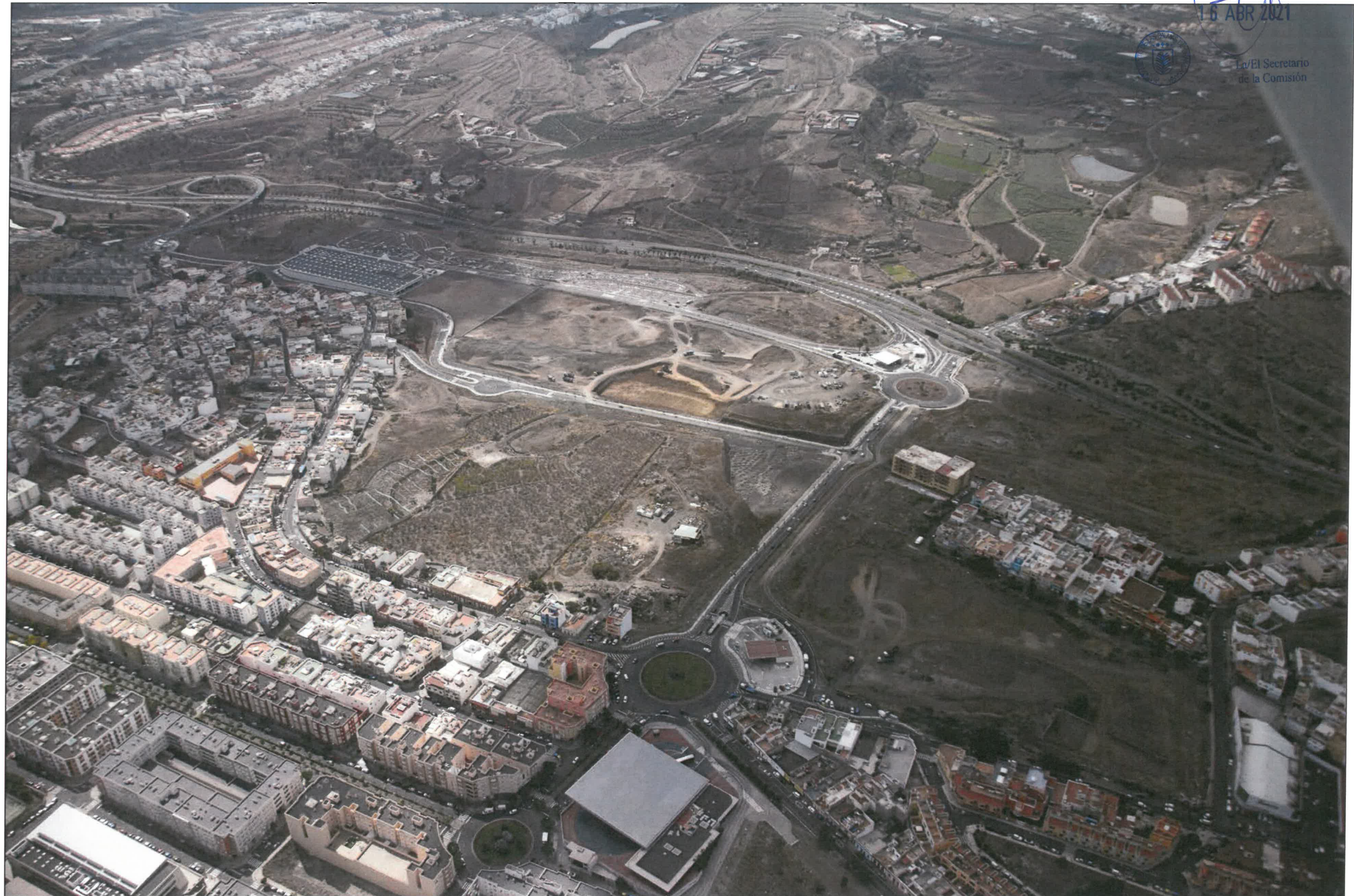
Situación ambiental de referencia. Vista aérea 2.
