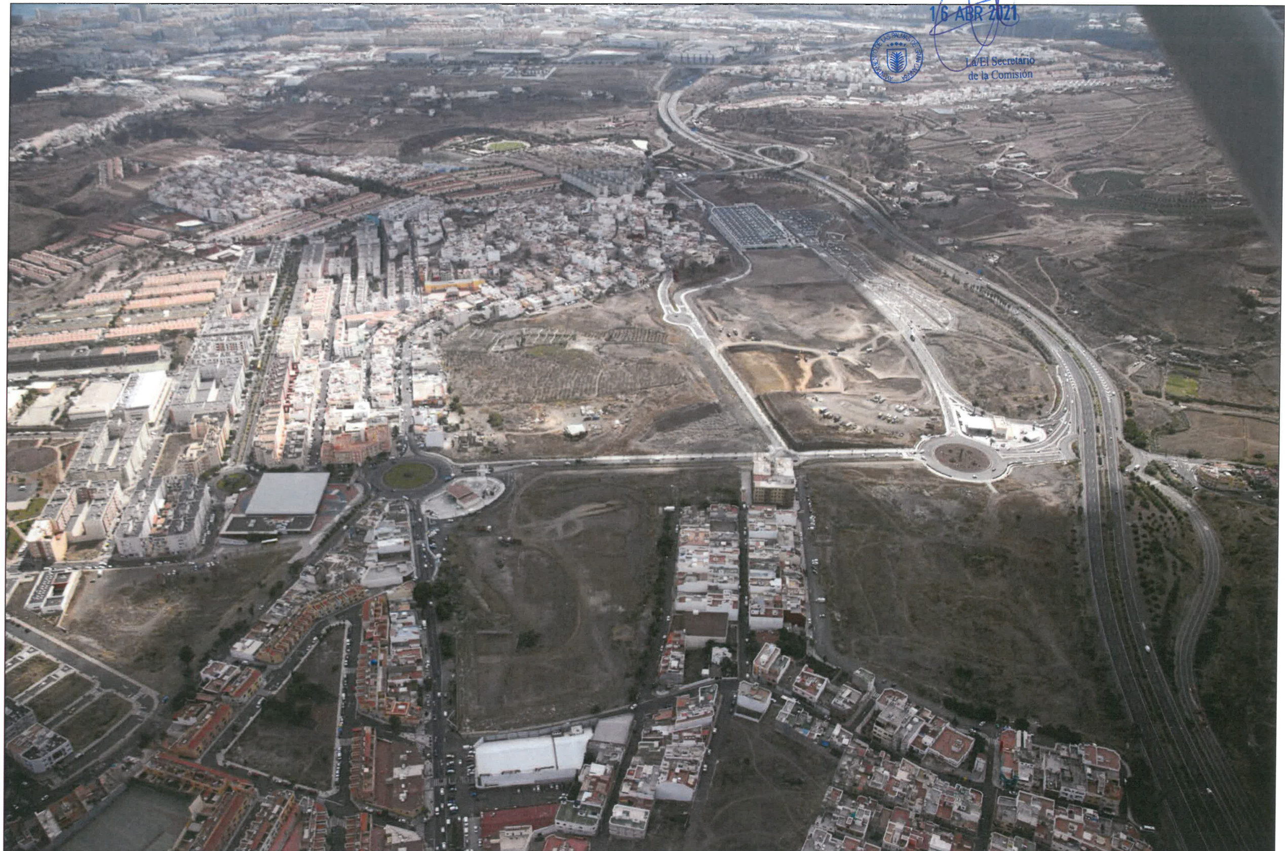
Situación ambiental de referencia. Vista aérea 3.
