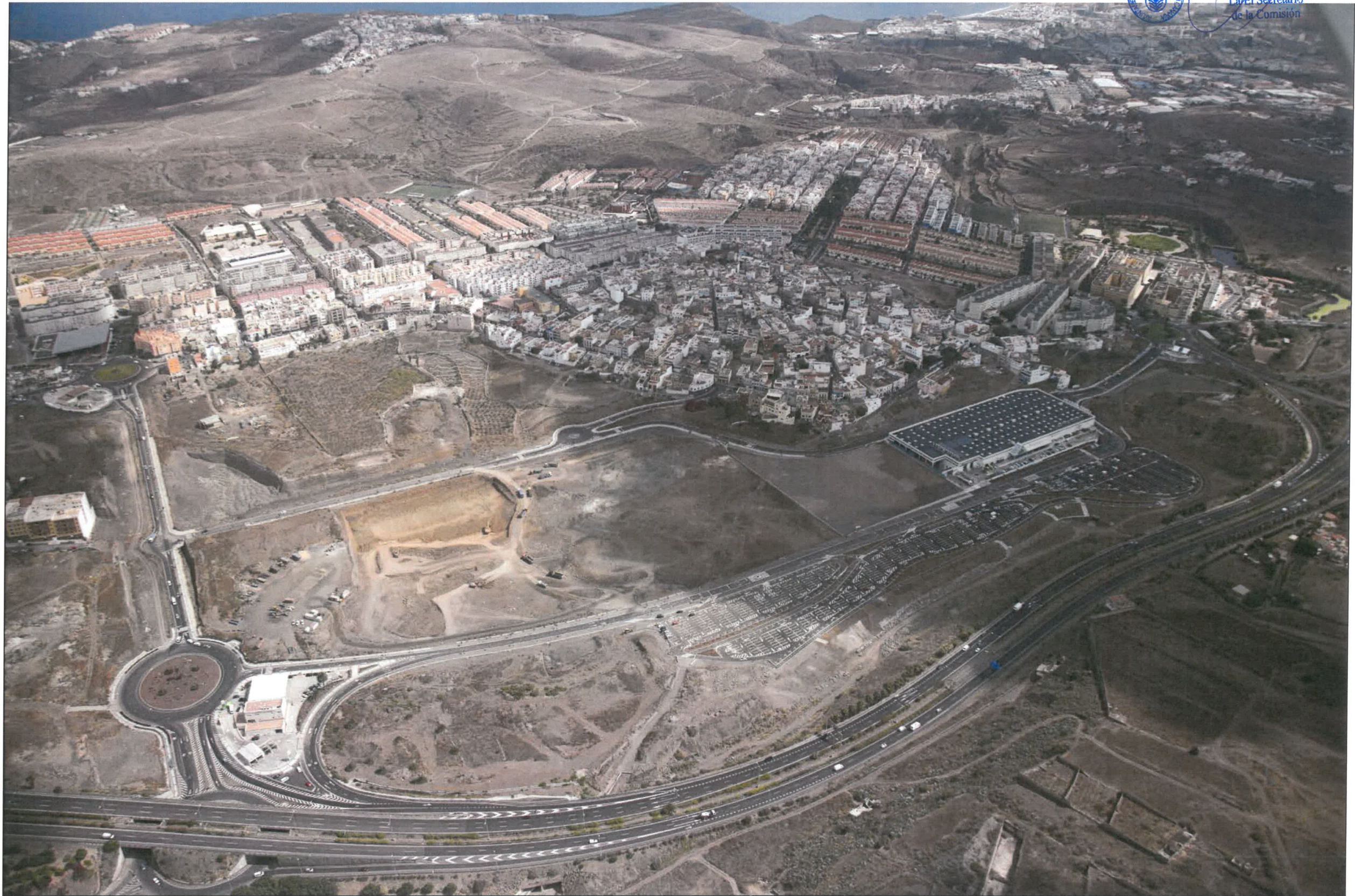
Situación ambiental de referencia. Vista aérea 1.
