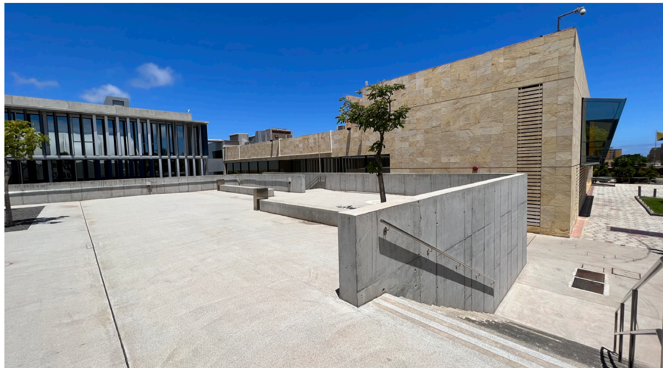
Vista de la escalera ubicada entre la plaza del edificio Pasarela y el Palacio de Congresos. Fuente: LPA Studio.
