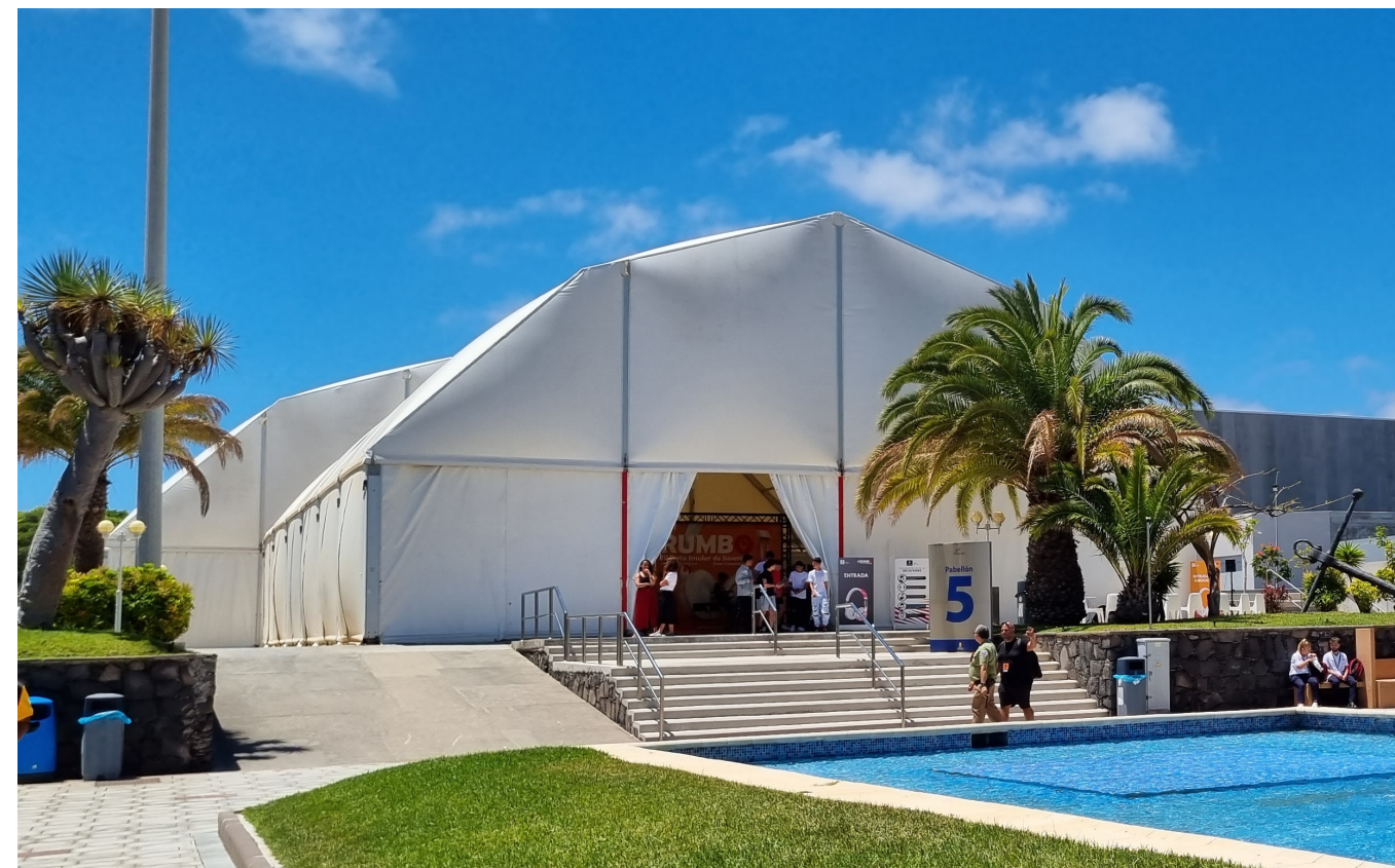
Problemática funcional: Pabellón 5 (provisional) en forma de carpa. Fuente: LPA Studio.
