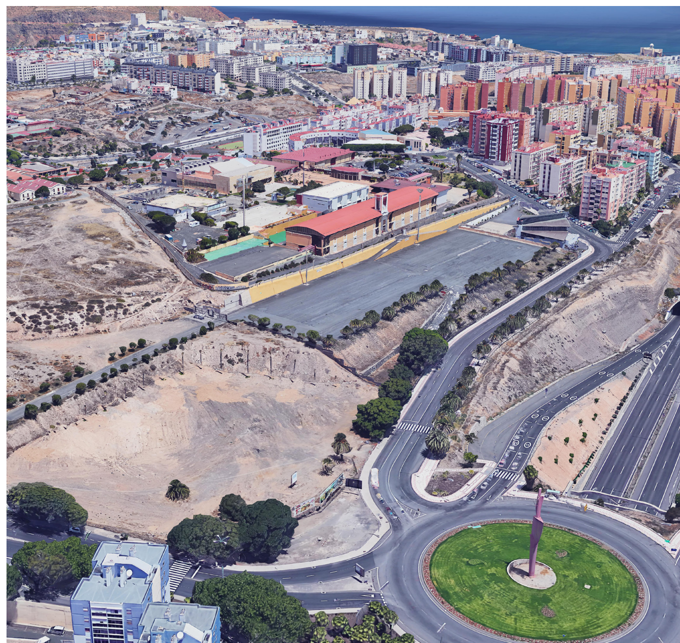
Imagen aérea del ámbito de ordenación, donde se aprecia la cercanía a la rotonda. Fuente: Google Earth.
