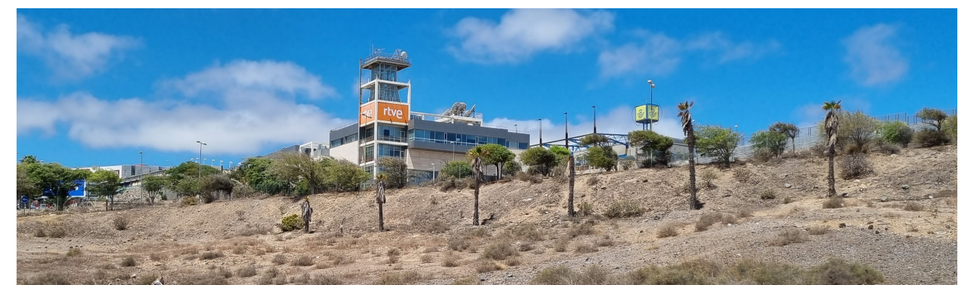
Edificaciones de RTVE y Correos vistas desde la zona sur del ámbito. Fuente: LPA Studio.
