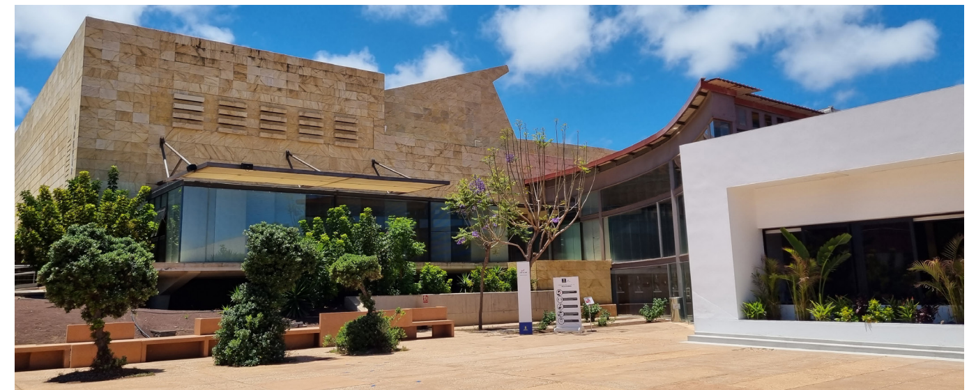
Palacio de Congresos, Hall Maspalomas y Pabellón 2. Fuente: LPA Studio.
