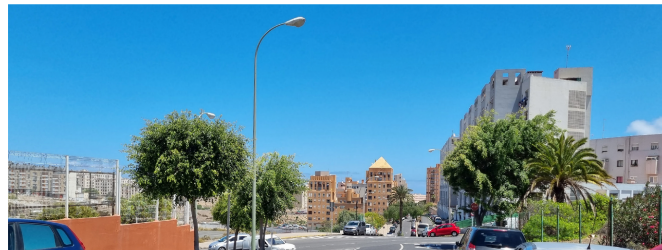
Alumbrado público exterior. Fuente: LPA Studio.
