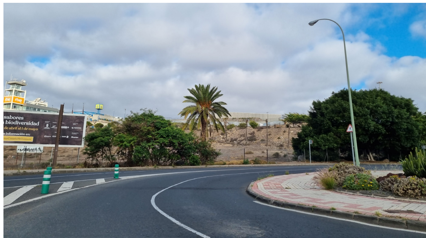
Acceso a Avenida de La Feria, vial que afecta al Recinto Ferial de Canarias, con riesgos bajos o nulos. Fuente: LPA Studio.
