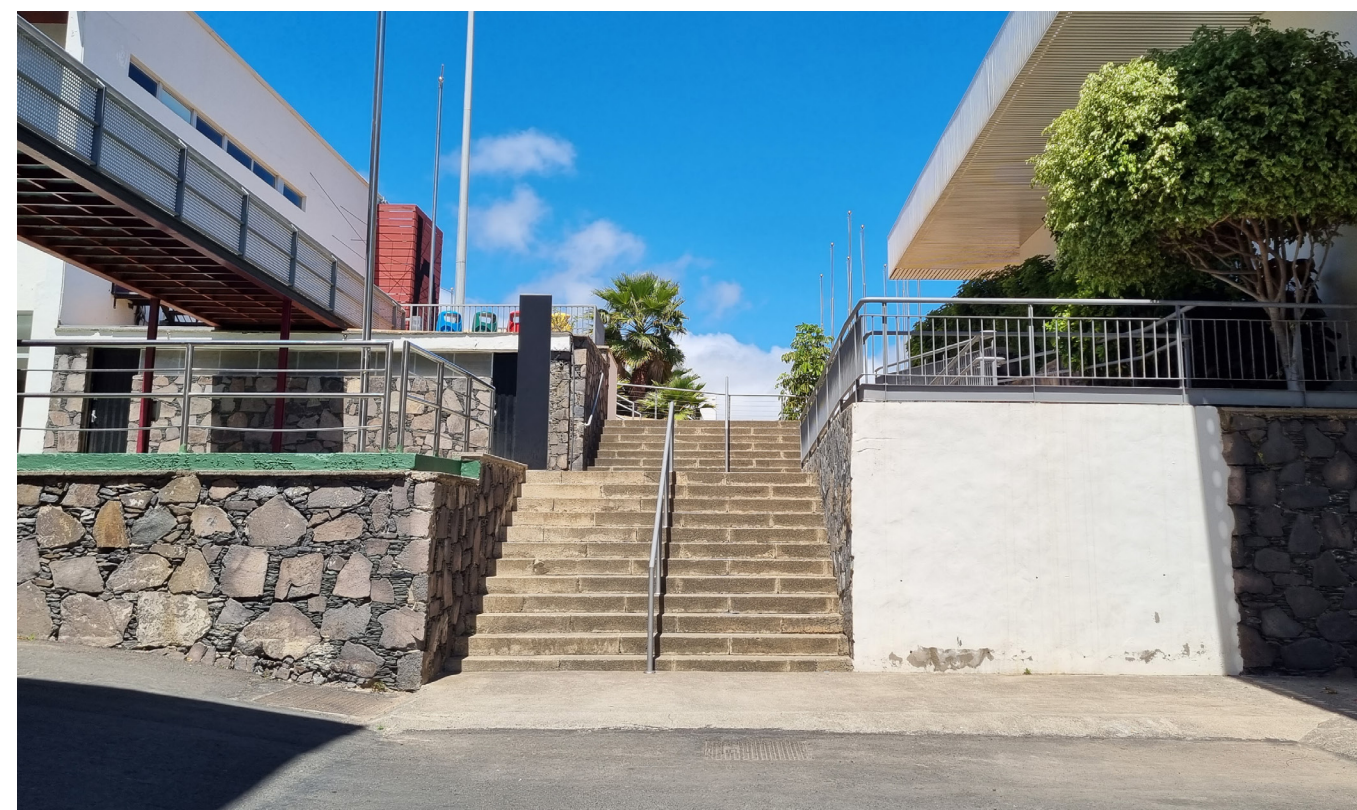
Problemática accesibilidad: escaleras existentes en el interior del Recinto Ferial. Fuente: LPA Studio.
