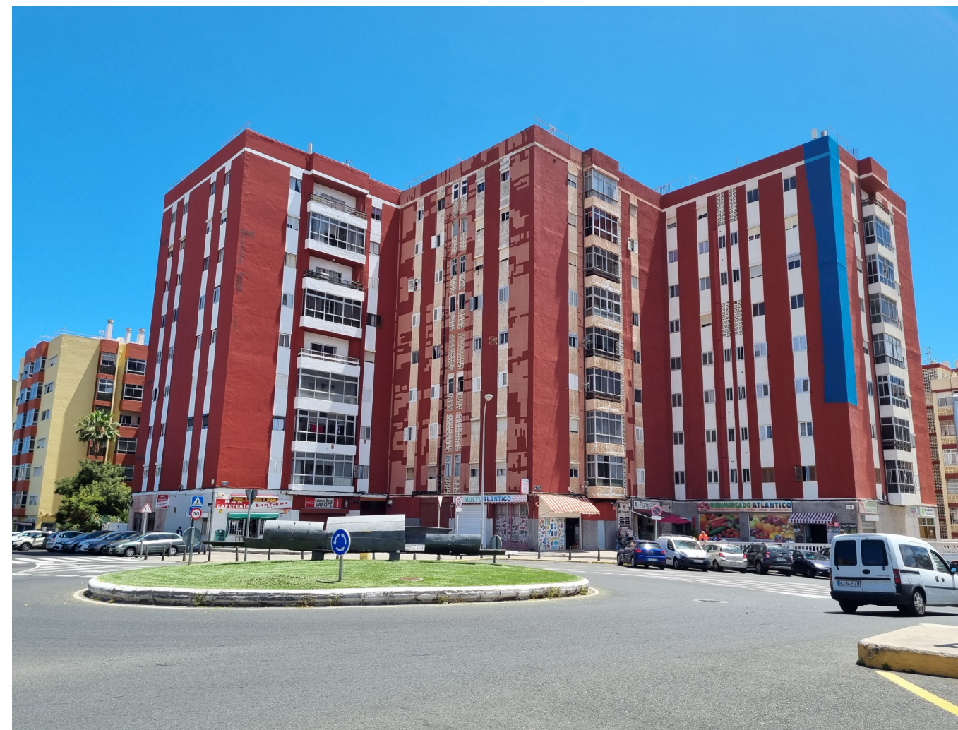
Barrio de La Feria del Atlántico, junto a la entrada norte del Recinto Ferial de Canarias. Fuente: LPA Studio.
