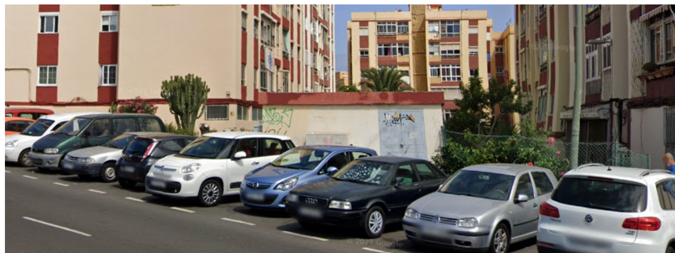
Estación de Media tensión ubicada en la Avenida de La Feria. Fuente: LPA Studio.
