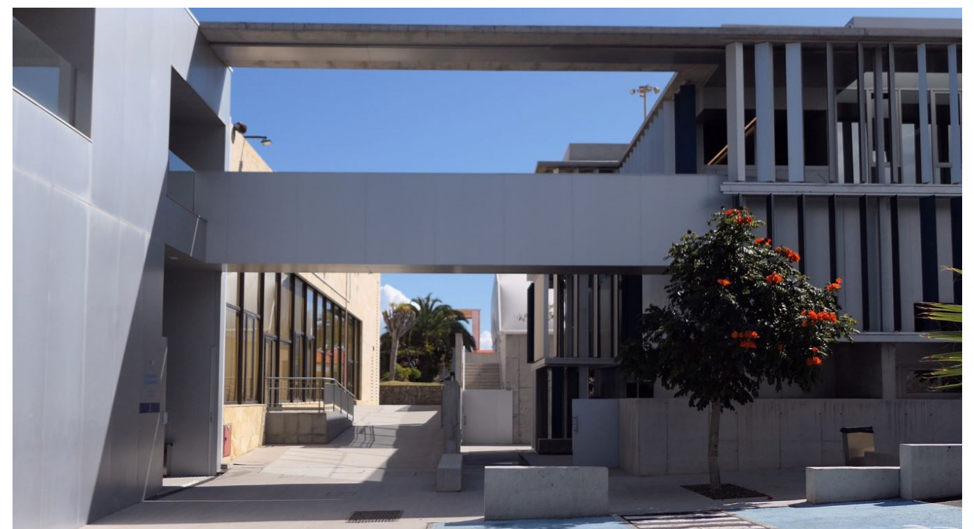
Edificios Incube y Pasarela. Fuente: LPA Studio.
