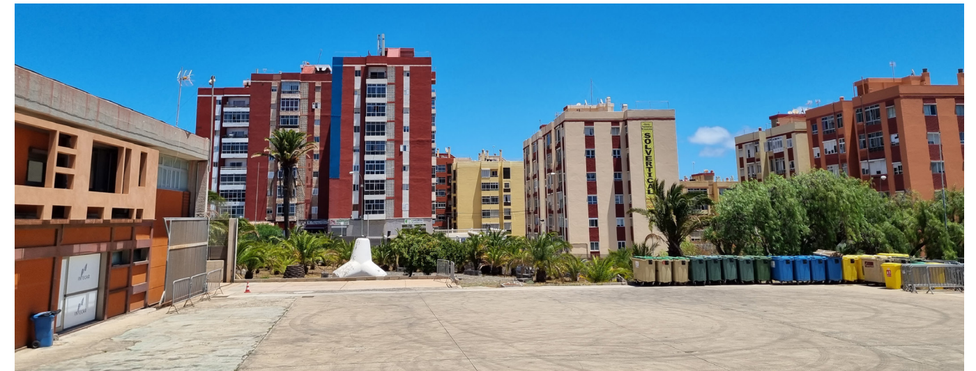
Imagen actual de las edificaciones residenciales situadas en las cercanías del Recinto Ferial. Fuente: LPA Studio.
