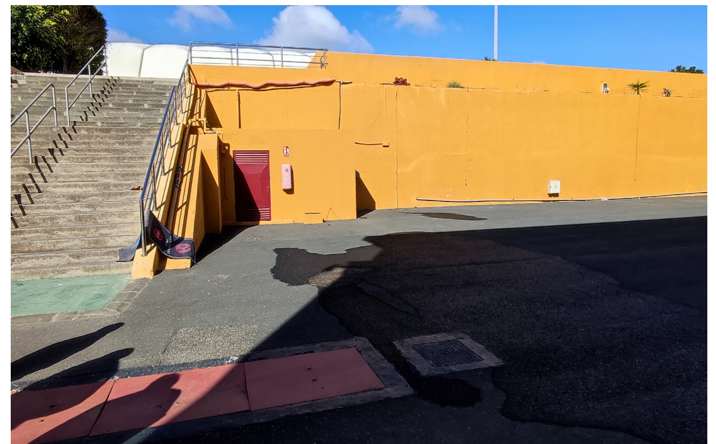
Zona de instalaciones donde se ubica el aljibe actual del Recinto Ferial. Fuente: LPA Studio.
