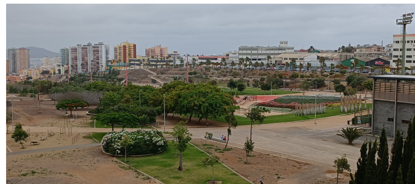
Parque Urbano de La Ballena, situado en el ámbito de estudio. Fuente: LPA Studio.
