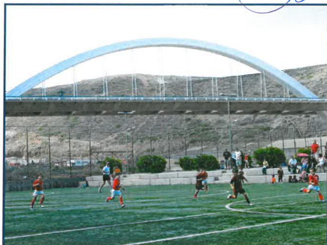
Figura 3. Canchas deportivas MANUEL NARANJO SOSA .
