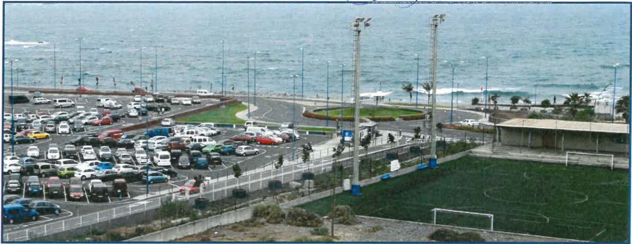
Figura 4. Nueva rotonda. Fuente: archivo propio
